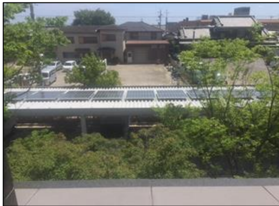
公共施設太陽光発電設備（市役所）
