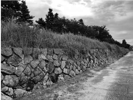
前浜新田干拓堤防護岸(碧南市川口町六丁目)
