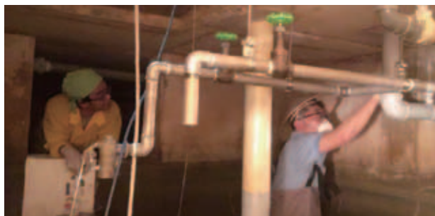
△蓄熱槽内の整備
