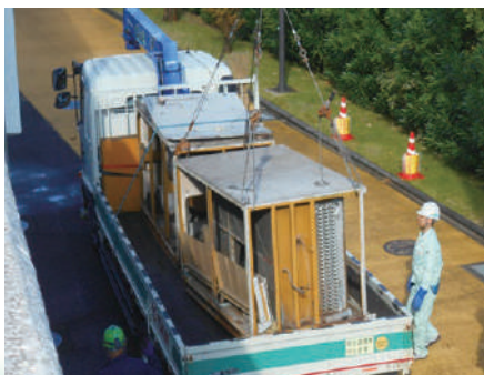
△旧機器搬出の様子
