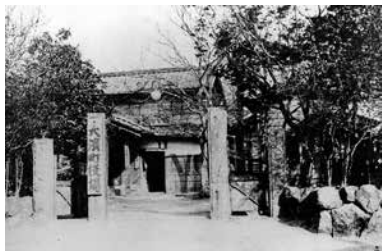
△現在の藤井達吉現代美術館の位 置に建てられた大浜町役場 昭和4年（1929）頃 昭和11年（1936）に老朽化のため 取り壊された。
