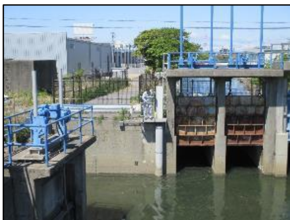
河川海域等水質調査（堀川水門）
