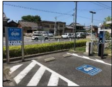
碧南市役所東駐車場 充電スタンド
