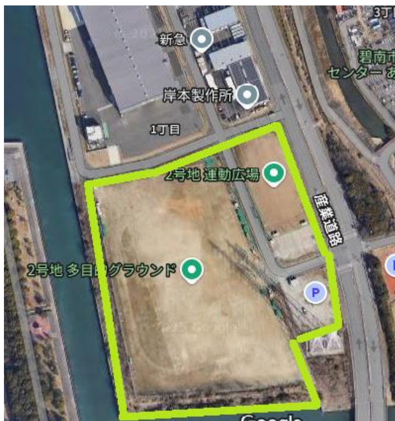
図 1-2 2号地多目的グラウンド航空写真
