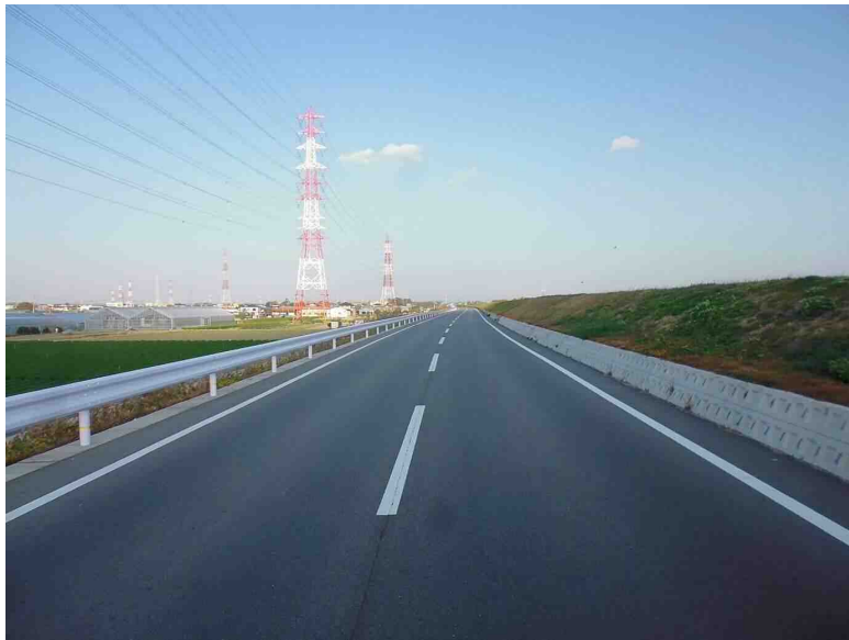
矢作川堤防リフレッシュ道路
