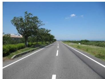
矢作川堤防リフレッシュ道路
