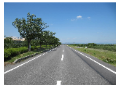
矢作川堤防リフレッシュ道路
