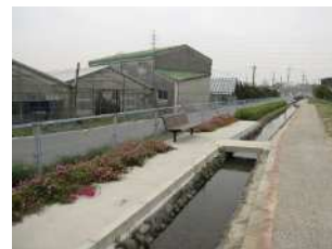
せせらぎ水路
