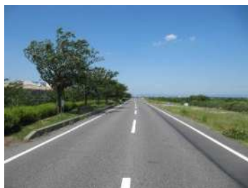
矢作川堤防リフレッシュ道路
