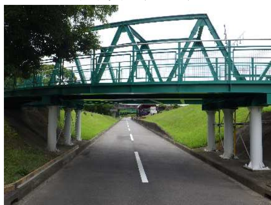
桁下状況（左起点）
