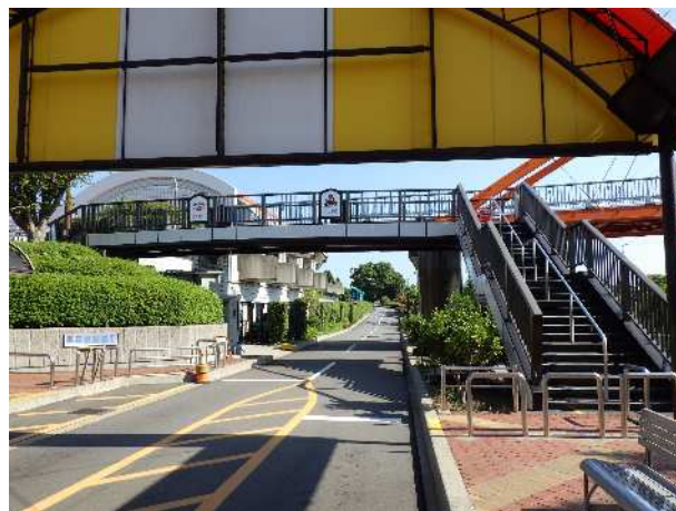
桁下状況（左起点）
