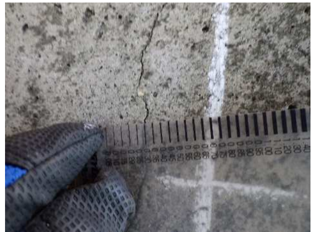
①②柱部・壁部：ひびわれ（ひびわれ幅 W=0.3\text{mm} ）
