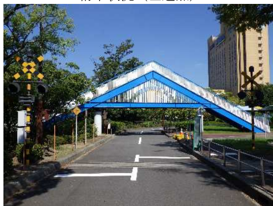
桁下状況（左起点）
