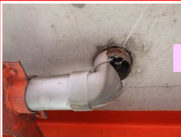
排水管：欠損
