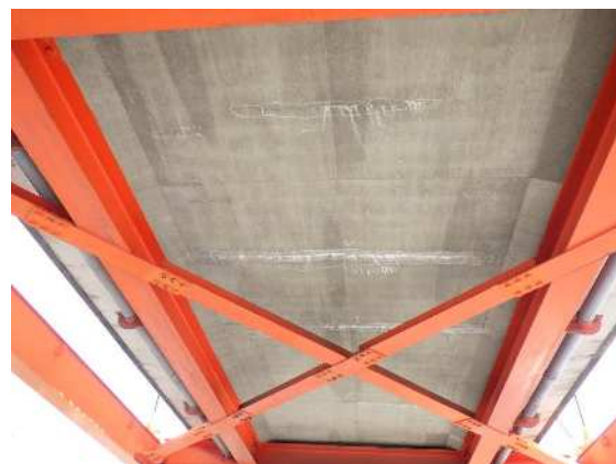
①②床版：床版ひびわれ、遊離石灰 （ひびわれ幅 W=0.1mm）
