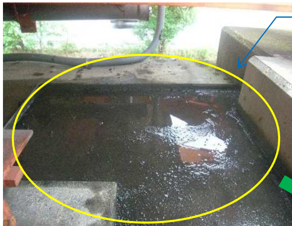
①柱部：壁部：漏水跡、土砂詰まり
