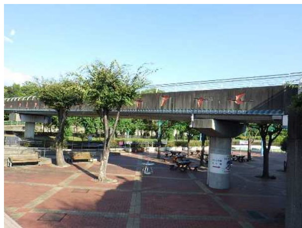
桁下状況 (左起点)
