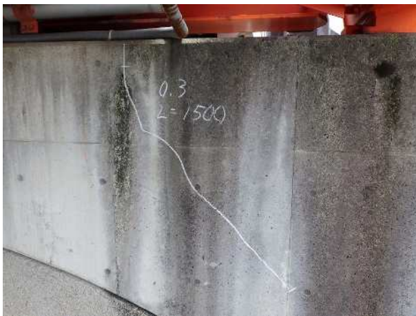
①②柱部・壁部：ひびわれ（ひびわれ幅 W=0.3\text{mm} ）
