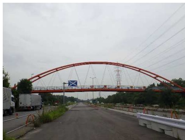
桁下状況（左起点）
