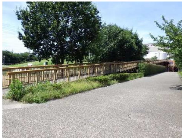
桁下状況（左起点）
