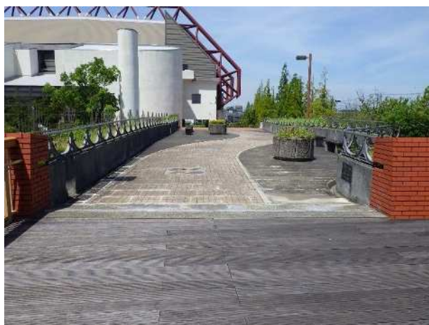
正面（起点側から撮影）
