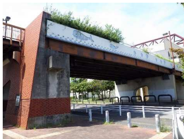
桁下状況（左起点）
