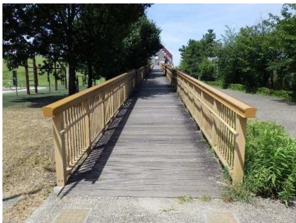
正面（起点側から撮影）
