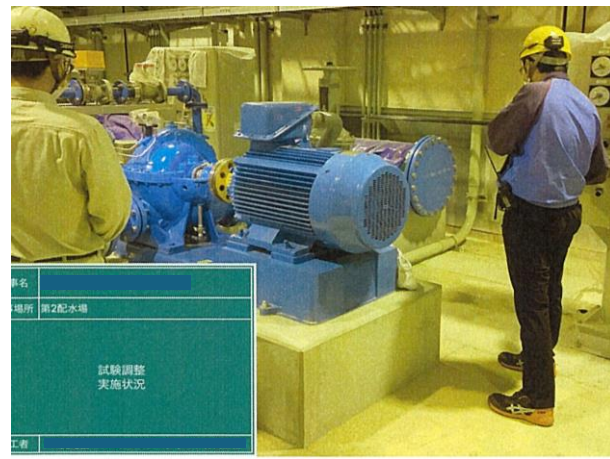
配水場の設備更新
