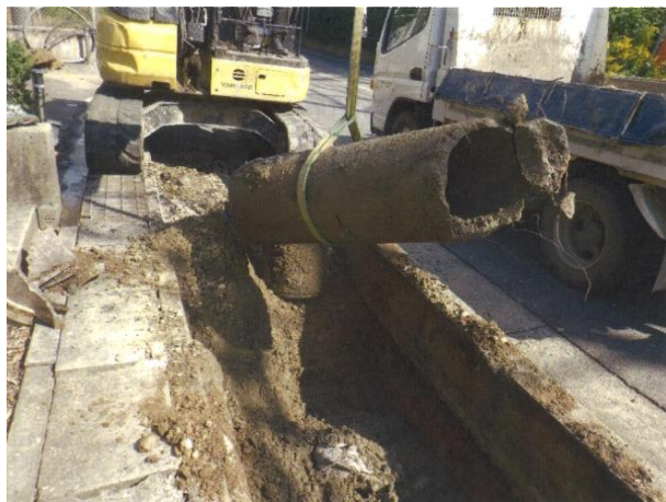
老朽管の更新工事
