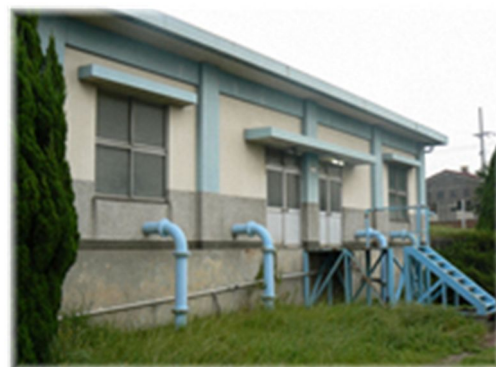
第1配水場 配水池
