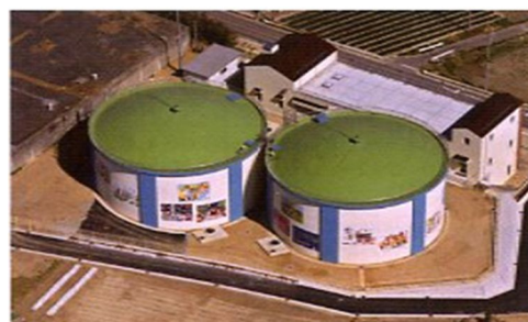
第2配水場 配水池
