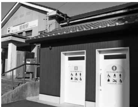
△名鉄碧南駅前の公衆トイレ
