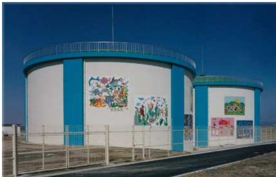
第2配水場配水池
