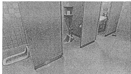
エメラルドホール女性用トイレの現状
