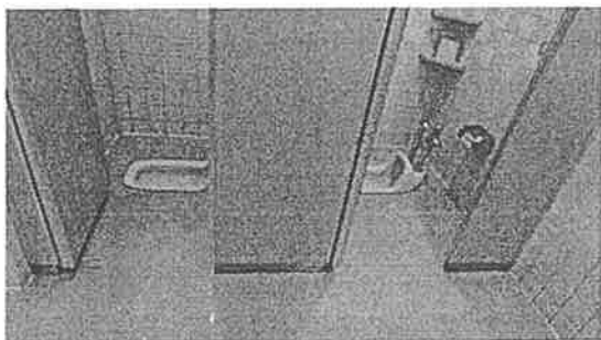
シアターサウス女性用トイレの現状
