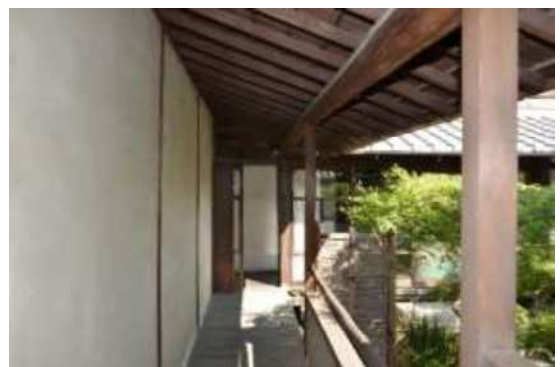
鈴木家住宅裏座敷及び渡り廊下
