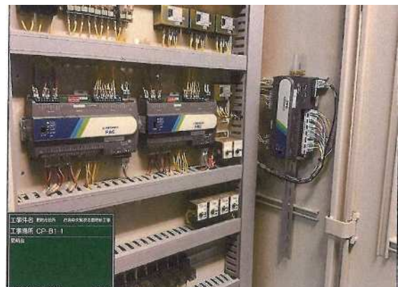
中央監視装置更新工事（熱源機械室内）
