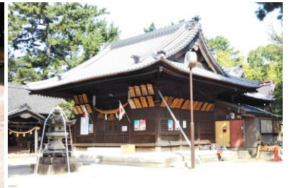
完成屋根の全体写真
