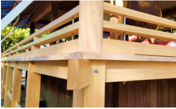
組立て縁側のガタ修理(更新)
