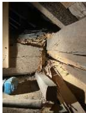
腐食により丸太梁が下がる
