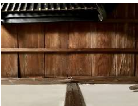
東面内部天井 丸太梁の重みで廻縁が割れる
