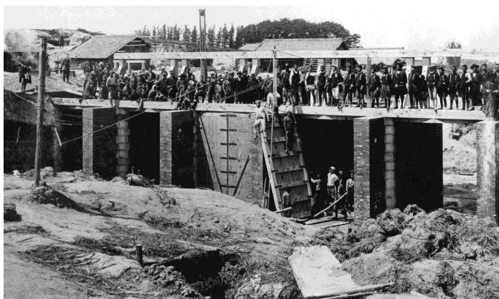
新堀川権江橋上流の水門工事（明治 43 年 1 2 月撮影）
