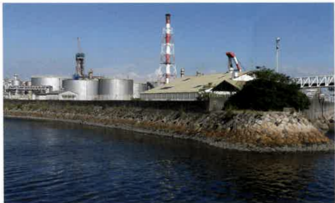
四日市旧港潮吹防波堤 重要文化財 (画像提供: 四日市港管理組合)
