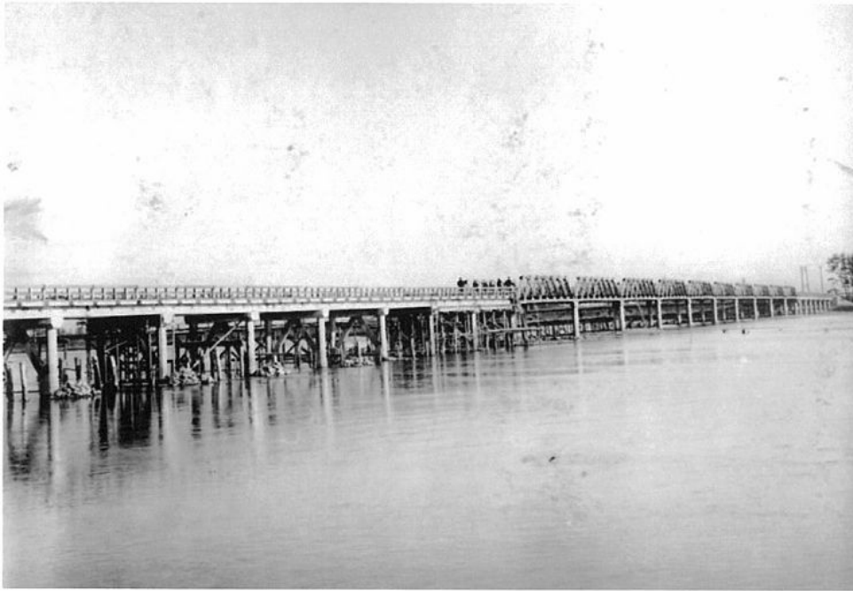
完成なった 二代目棚尾橋
