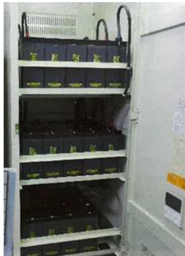
庁舎直流電源装置蓄電池等取替工事
