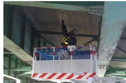
【橋梁の定期点検】
