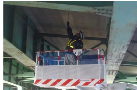
【橋梁の定期点検】
