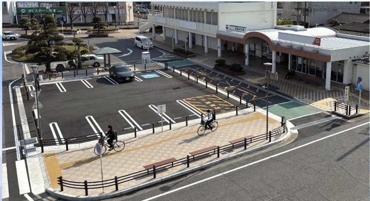
碧南中央駅前にあったポケット広場を駐車場に整備しました。（写真）
