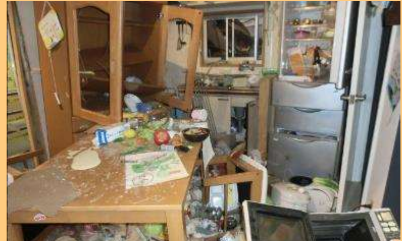
固定していない家具の転倒・物の散乱
