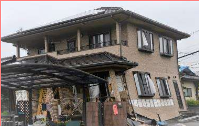
耐震性の高い建物も倒壊の可能性
